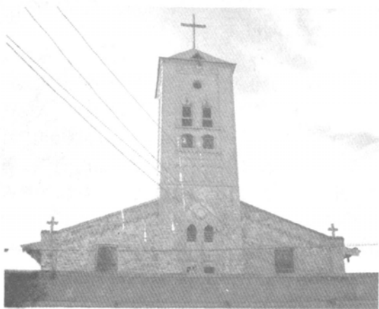
图1 主教堂钟塔外观
