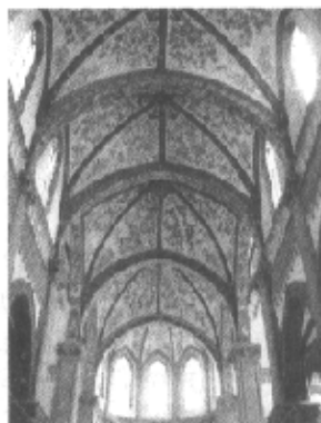
图 4 尖拱券组成的室内天花
