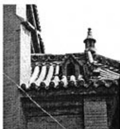
图 5-24-2 老虎窗二 Figure5-24-2 Window of Ventilation
