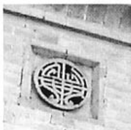
图 5-25-1 通气孔一 Figure5-25-1 Ventilat
