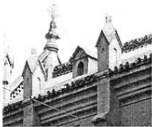
图 5-24-1 老虎窗一 Figure5-24-1 Window of Ventilation
