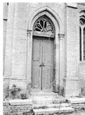
图 5-19-2 入口大门二 Figure 5-19-2 Entrance
