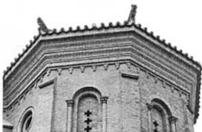
图 5-10-1 屋顶檐口一 Figure5-10-1 The Eaves' Form
