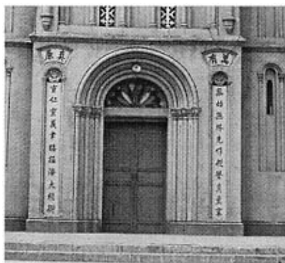
图 5-19-1 入口大门一 Figure 5-19-1 Entrance
