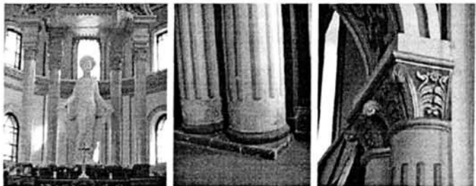
图 3.21 太原天主教堂各位置的柱, 依次为外壁柱、内壁柱、中厅一层券柱、中厅二层壁柱
