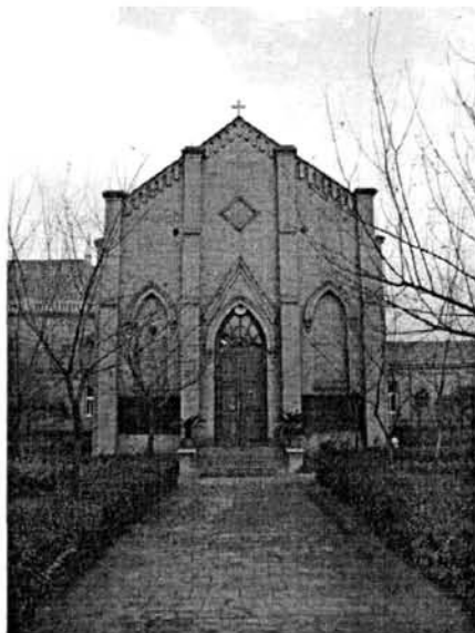
图 3.66 下庄修道院小教堂正立面
