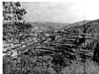
图 4.3 水沟村北面盘山道
