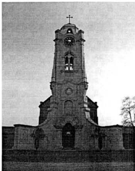
图 3.60 下庄寺修道院大教堂立面
