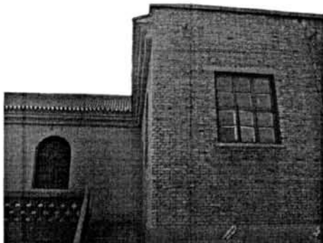
图 3.34 圪窰沟教堂（旧堂）墙壁
