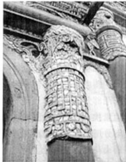
图 6.3b: 正立面入口柱子 2
