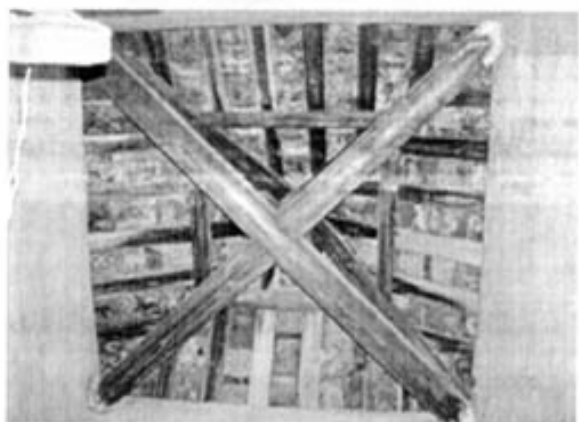
图 6.19: 钟楼屋顶木结构
