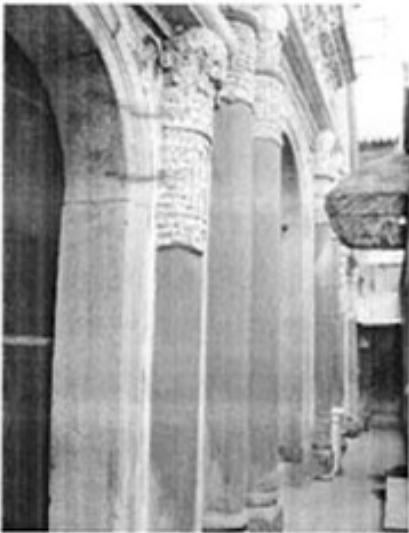
图 6-3a: 正立面入口柱子 1
