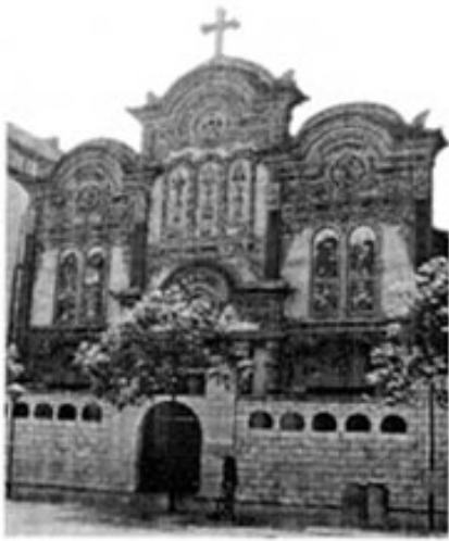
图 6.1: 拱星街圣体堂正立面
