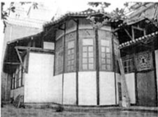
图 5.14: 江安天主堂祭坛外立面
