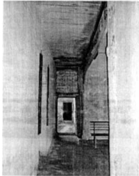
图 6.30: 通往楼梯的通道
