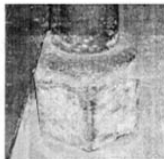
图 5.33: 江安天主堂柱基
