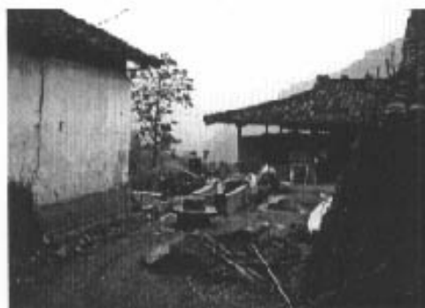
教会资助修建的自来水设施
