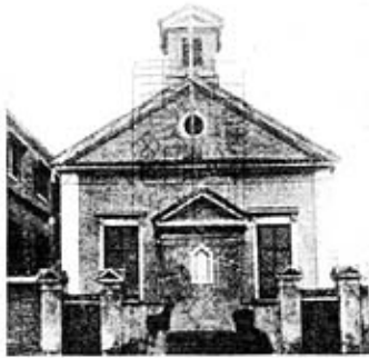
图 3.6 1874年建成的第一浸会堂
