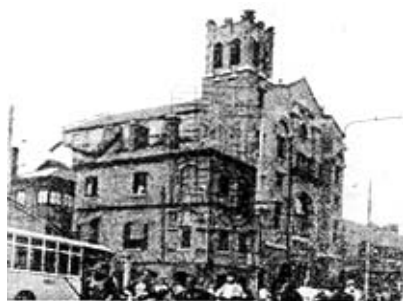
图4.5 1913年拆除重建后的第一浸会堂
