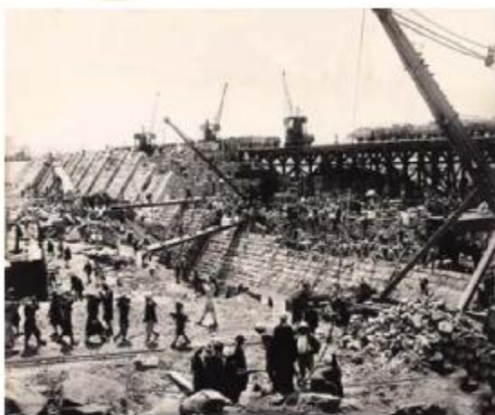
◎修建中的阿斯旺水坝 阿斯旺水坝，这个建在奔腾咆哮的尼罗河上的伟大工程，以其巨大的躯体横截尼罗河水，气势雄伟壮观。登上耸立于河岸上的水坝纪念塔，环形的拱桥式大坝像跨越尼罗河的长龙，豁然入目。阿斯旺水坝于1960年开始建造，竣工于1970年，在世界大坝中排名第11。但是它的坝面积超过了它的坝高，长度则跨越了尼罗河2英里。是因为修建中的阿斯旺水坝。
