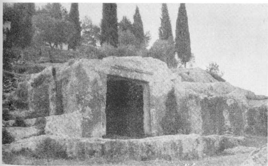
耶路撒冷古墓入口
