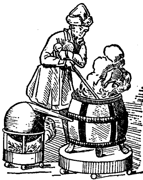
图 284—汽堆(左)给熔铜炉吹风
