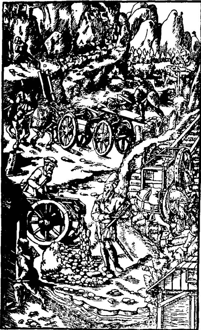
图 264—矿山地面运输
