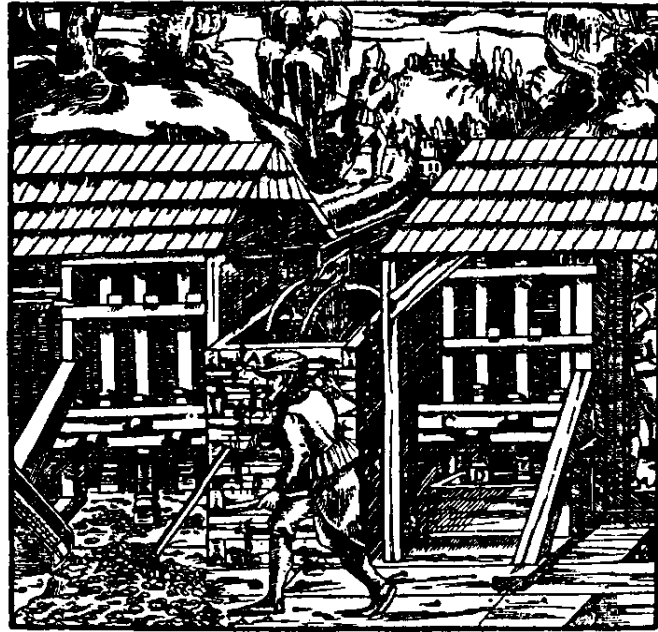
图 251—水车驱动的捣矿机
