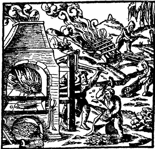
图 255—铋或铁矿石的熔炼炉
