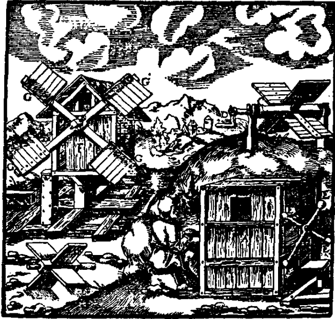
图 274—风车驱动的扇风机
