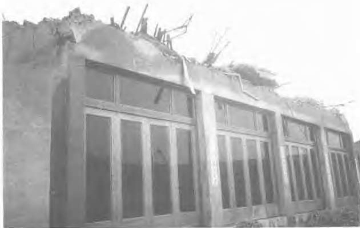
■ 信徒家樓上聚會處被拆（1996）
