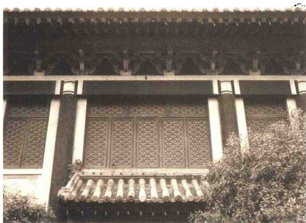
图 6-1-27 南京金陵女子大学主楼。檐下的斗拱不置于柱顶之上而与柱头错位均匀排列。照片由作者摄于 2001 年。
