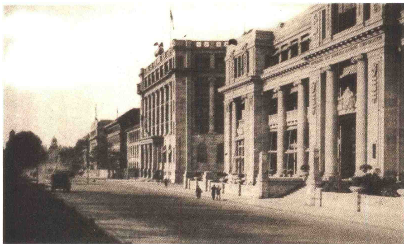
图 2-2-29 明信片中所载租界区沿江大道街景照片。原图载《老明信片·建筑篇》。
