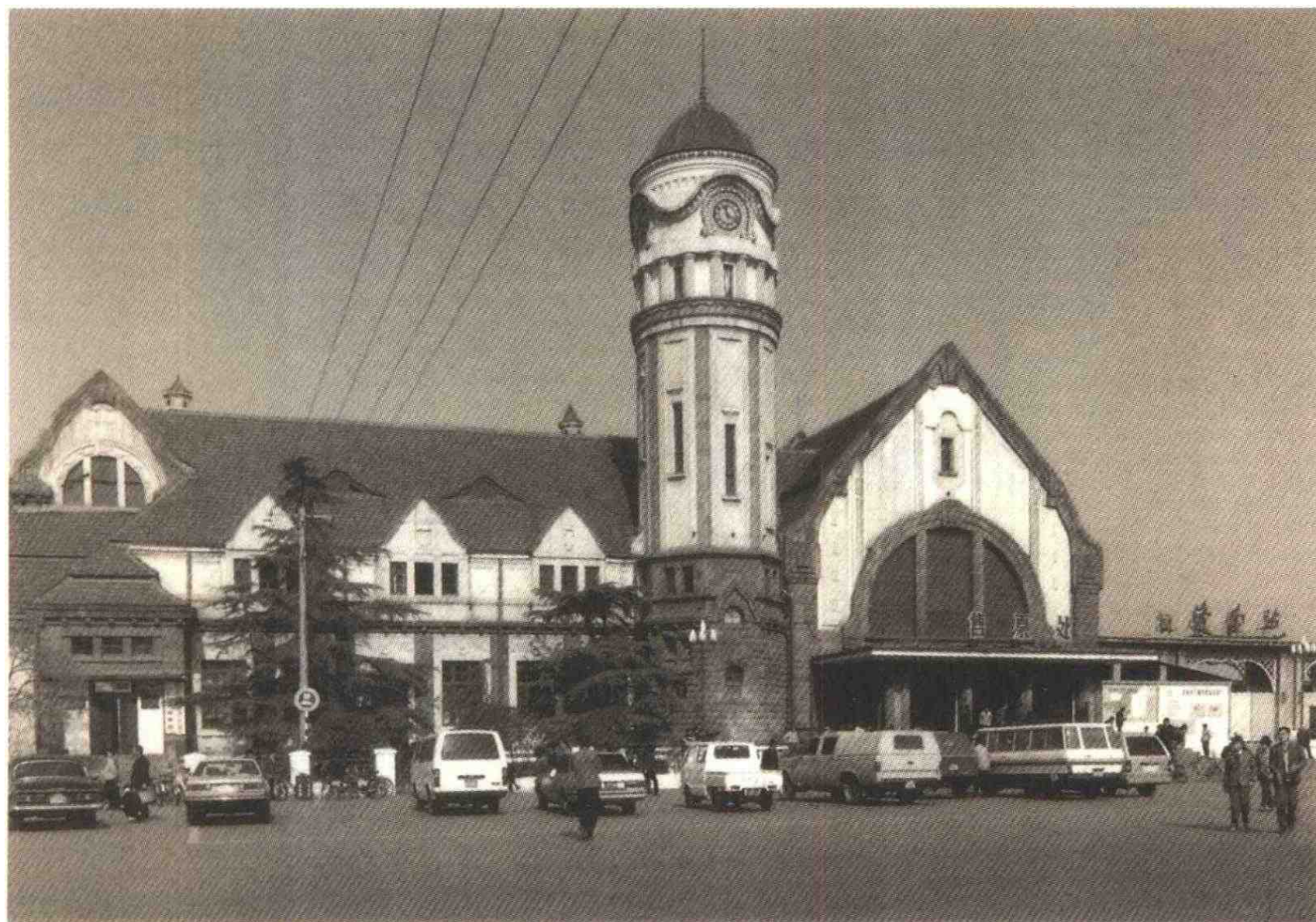
图 2-3-3 津浦铁路济南火车站。已拆除,照片由作者摄于 1992 年。
