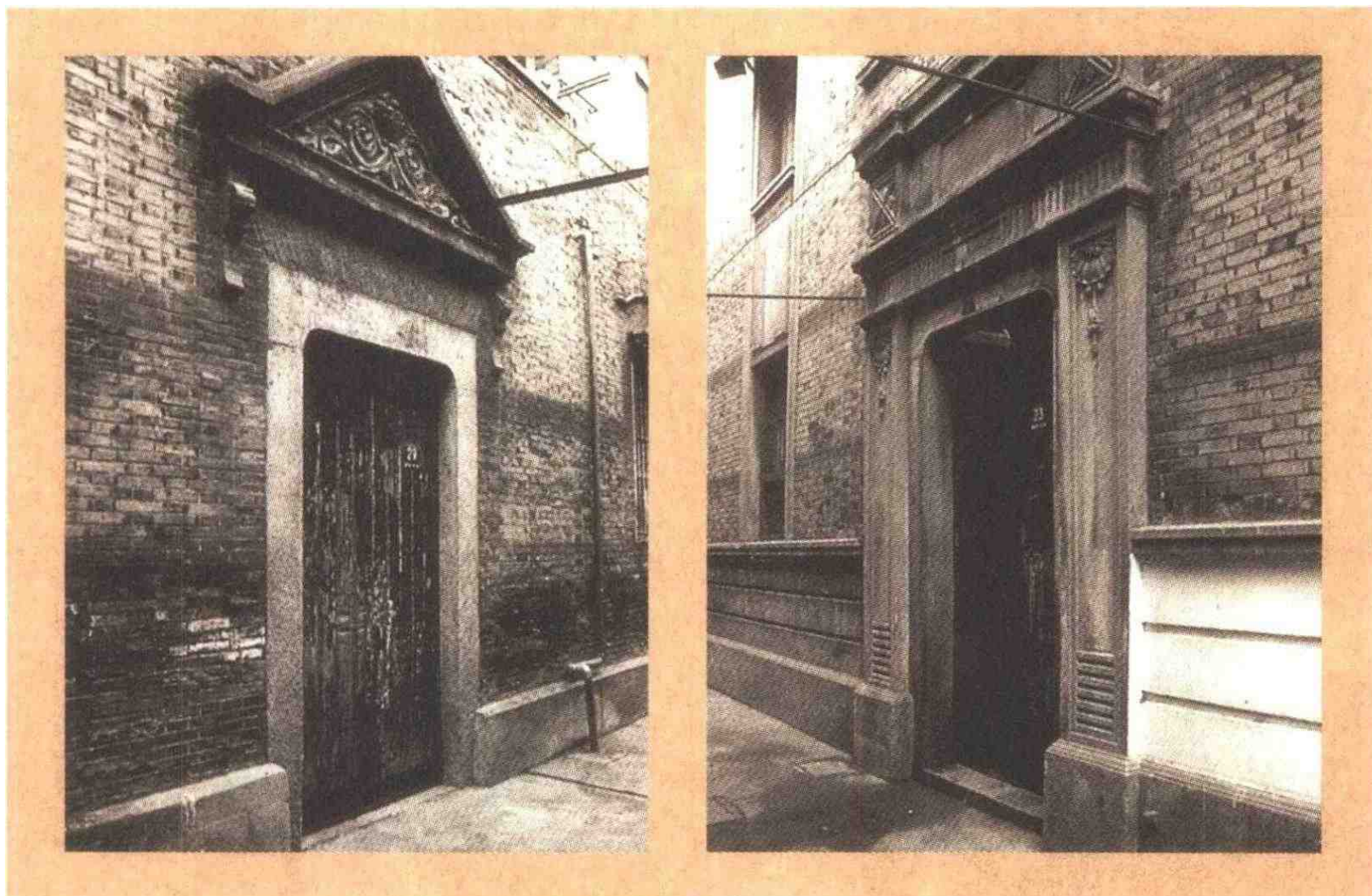
图 5-4-6 上海尊德里石库门之一。黑色实拼木门依旧, 石雕雀替取消, 条石门边框、门过梁简化。砖雕西式古典三角形山花砖工精细, 颇富美感。照片由作者摄于 1995 年。(左)
