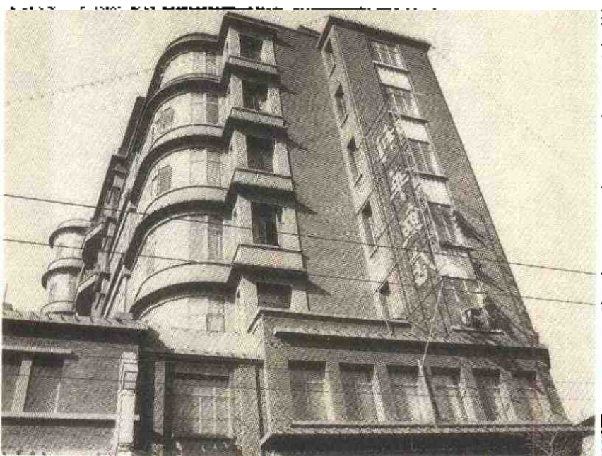
图 4-3-33 天津利华大楼仰视照片。照片由作者摄于 1989 年。
