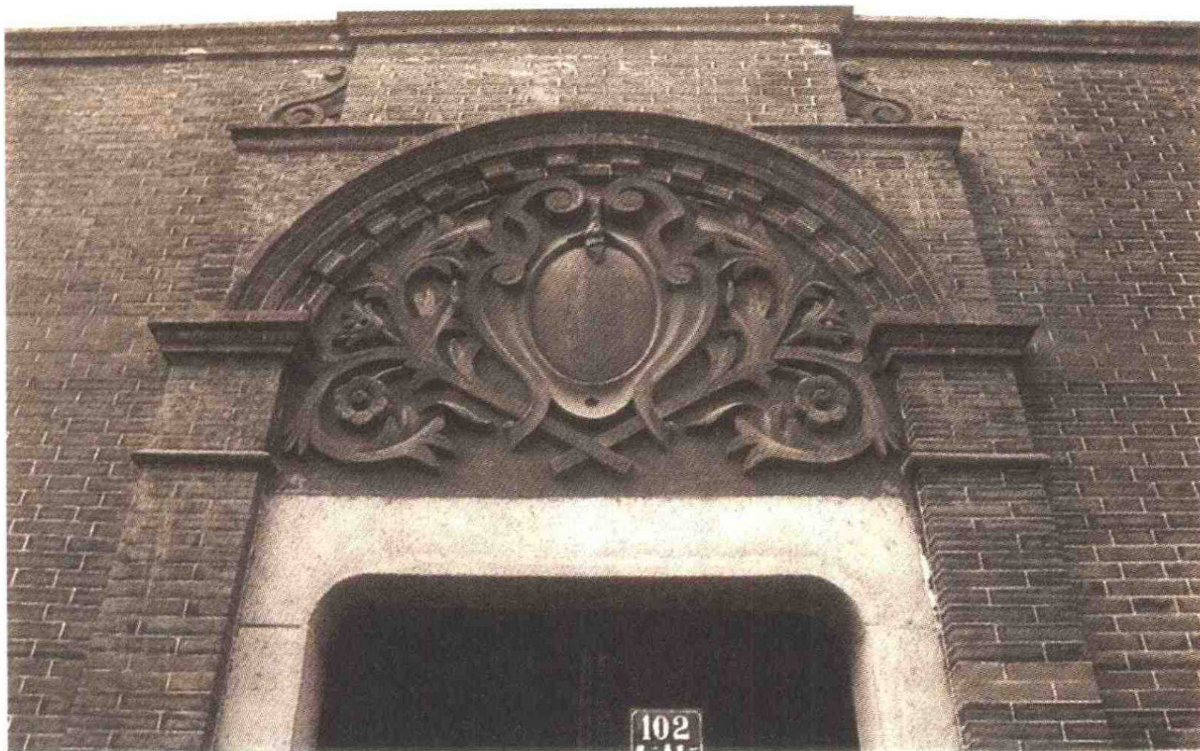
图 5-4-5 上海兴业路 102 号石库门, 中国传统砌砖工艺, 西化的装饰, 砖工精细。照片由作者摄于 1995 年。
