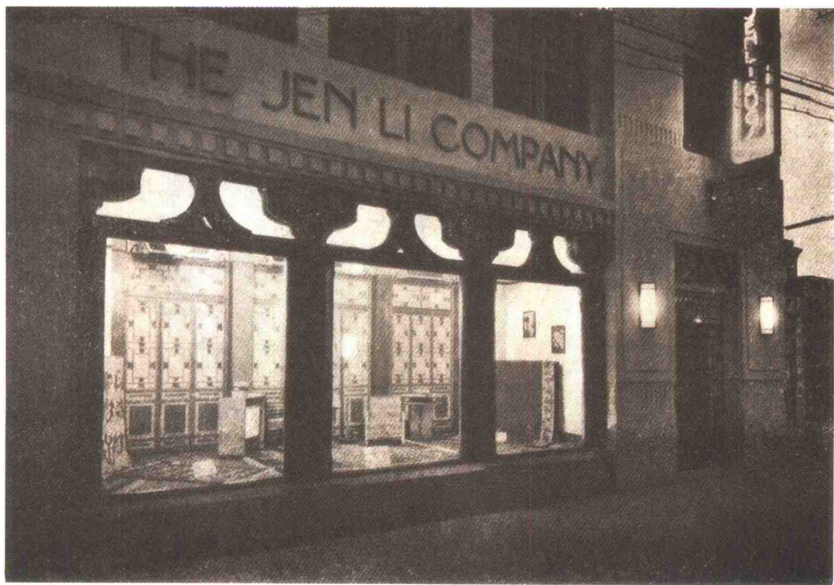
图6-3-51 北京仁立地毯公司铺面改建。正门及陈列室夜景。原图载《中国建筑》,第二卷,第一期,1934年1月。
