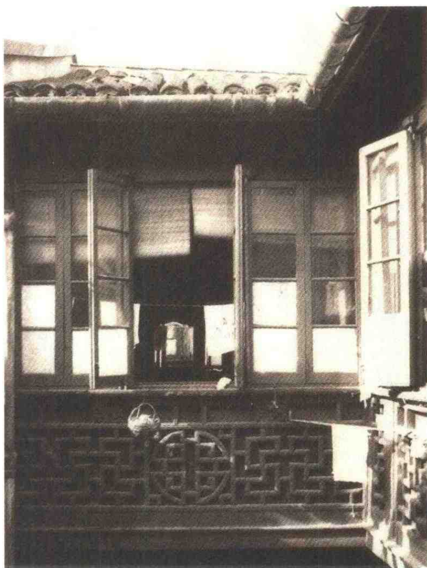
图 5-2-9 上海公顺里二层厢房木窗及窗下栏杆，采用中国传统建筑花饰纹样，精致的木栏杆体现了江南民居素雅的装修风格。照片由作者摄于 1980 年。
