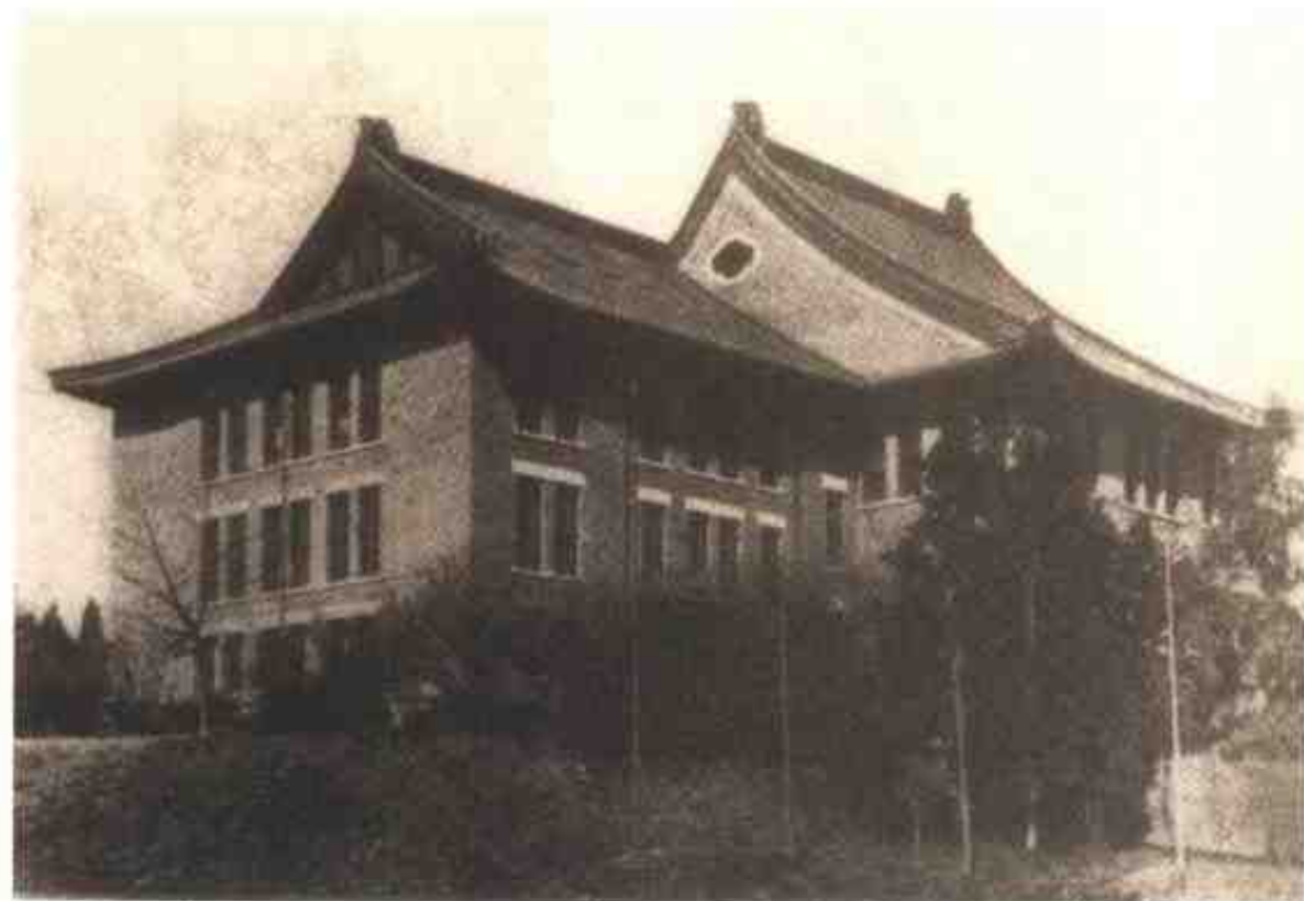
图 6-1-20 南京金陵大学东大楼背面外景。原图载《南京民国建筑》。
