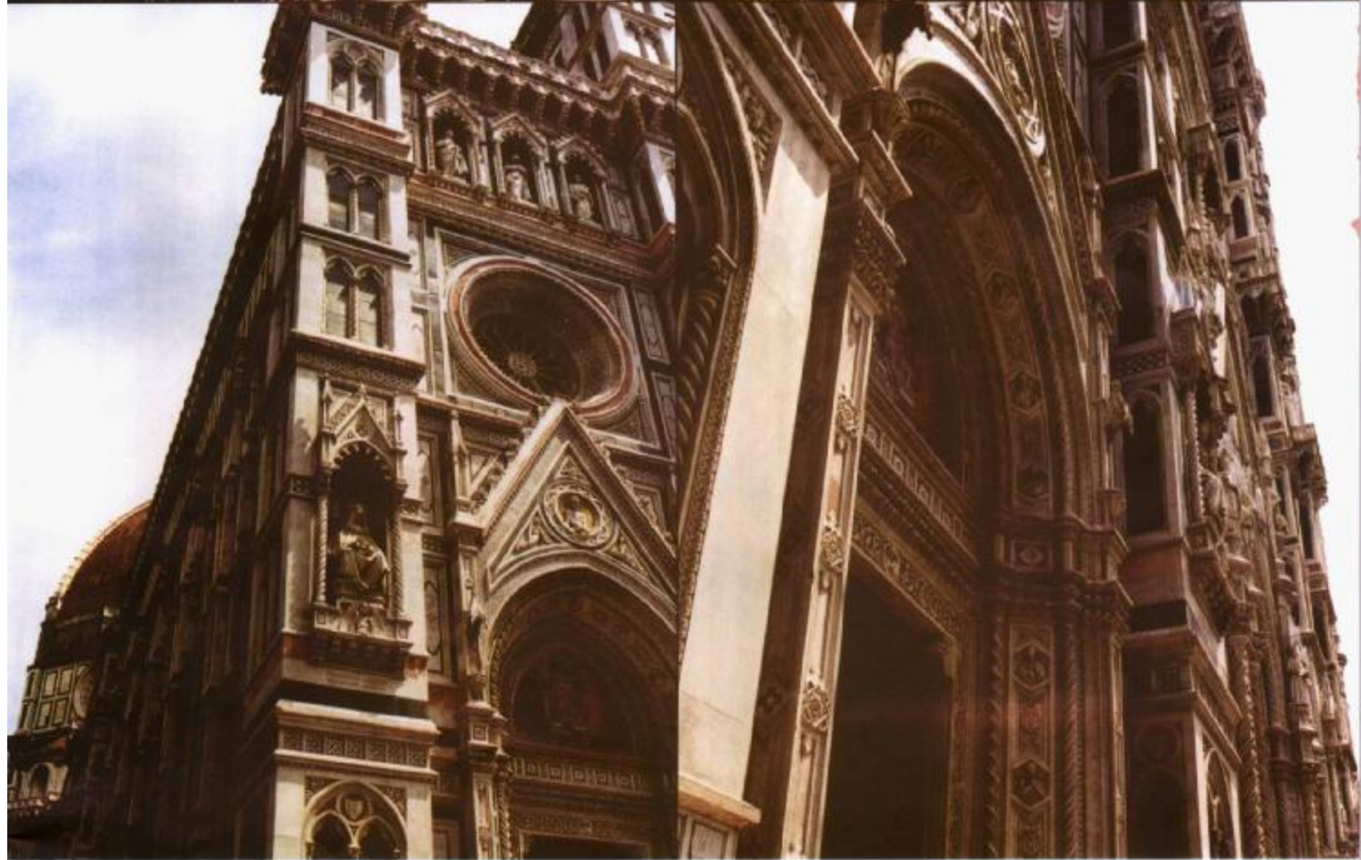
L09-08 教堂南侧立面, 墙面图案不断重复, 形成整体
