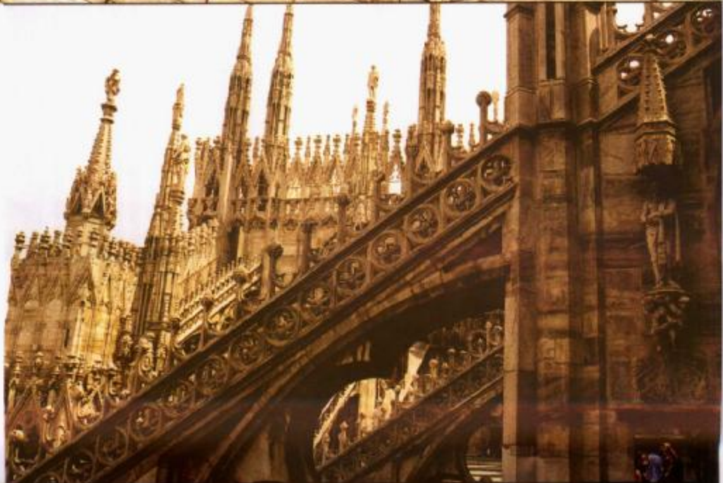
L07-11 侧屋顶石板瓦屋面呈台阶状 L07-12 连接屋顶交叉部塔楼的飞扶壁
