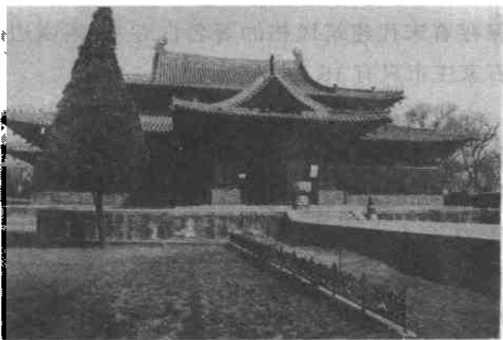
隆兴寺摩尼殿
